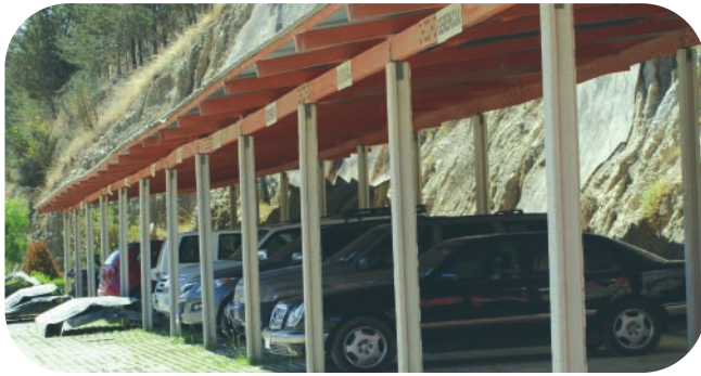
POSTES PMR para área de parqueos.
